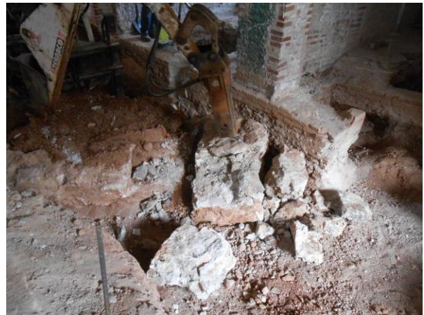
Foto 22. Desmuntatge de UE 123, 124 i 125
