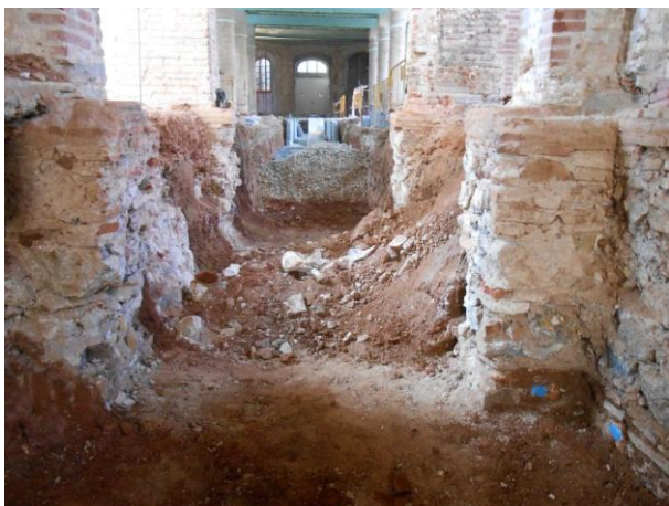
Foto 27. Detall de murs UE 121 i 133
