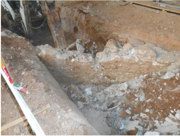
Foto 19. Desmuntatge de UE 115 i 116
